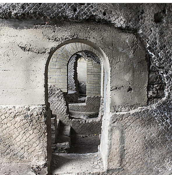
Cales, passaggi ad arco utilizzati per percorrere gli ambienti sotto la cavea, ricavati tra le strutture di sostruzione.
