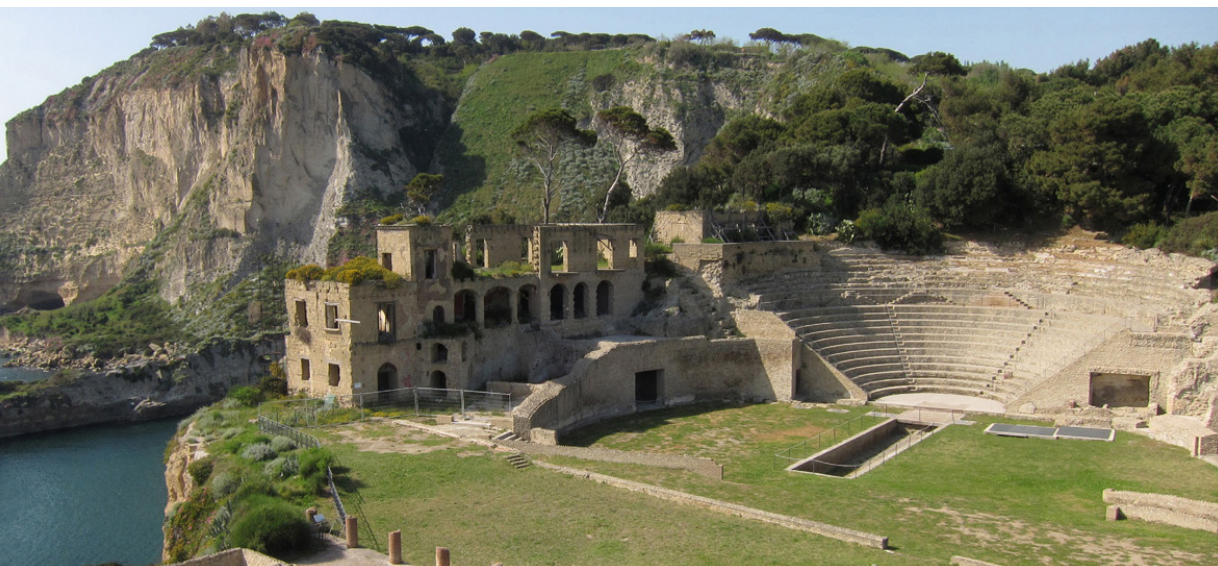
Pausilypon. Teatro realizzato a ridosso del pendio naturale, a sinistra edificio settecentesco.
